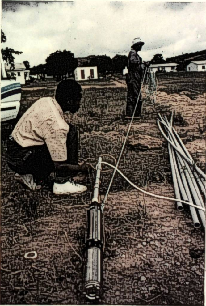
Vorbereitung der Wasser-Pumpe mit Motor.
