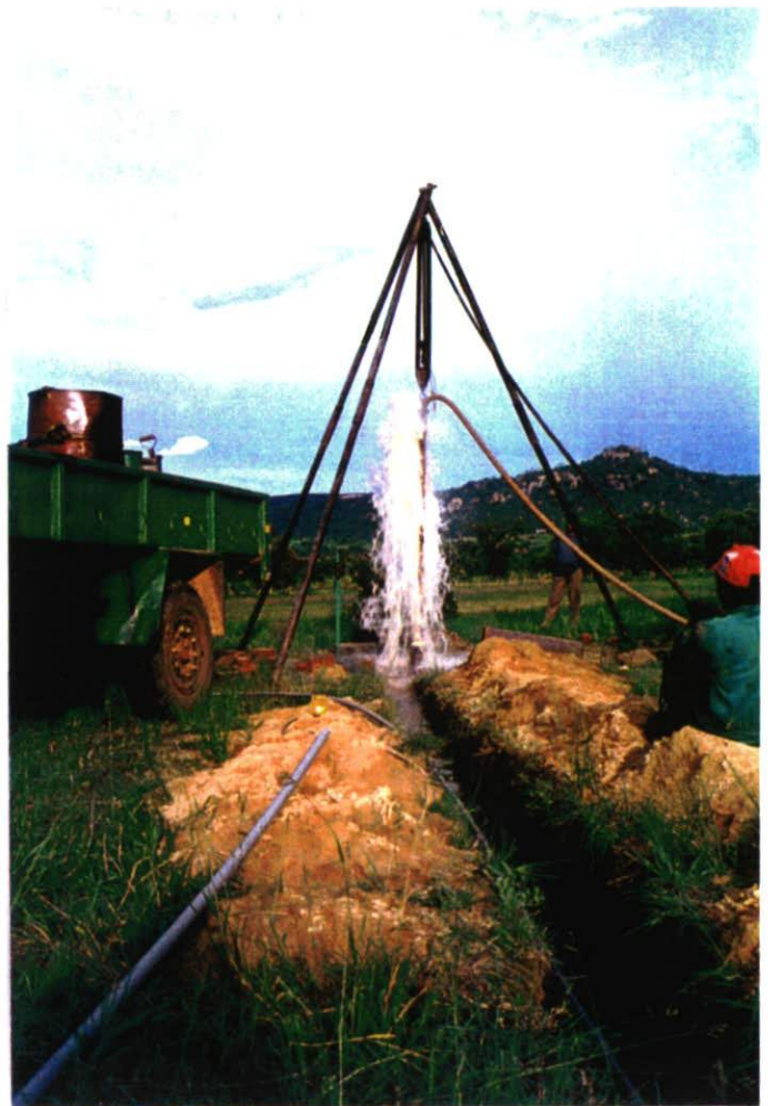
Das 50 Meter tiefe Bohrloch wird gereinigt und anschliessend ein Sickerrohr versenkt.
