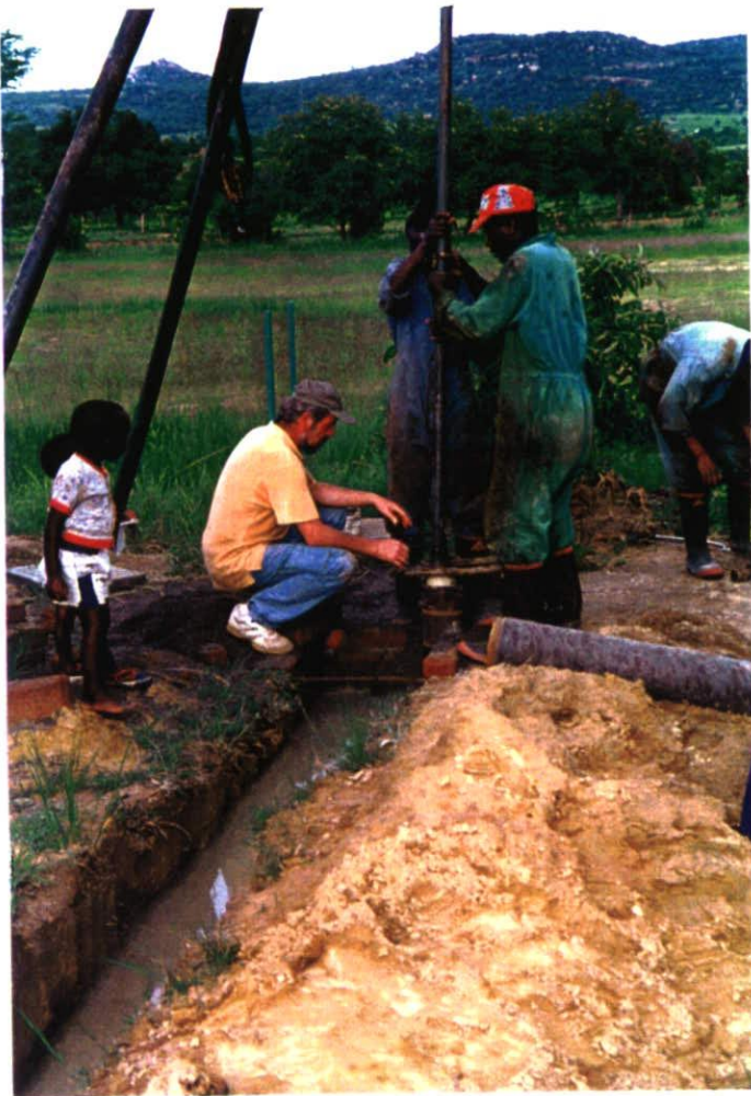
Versenken des Druckrohres.
