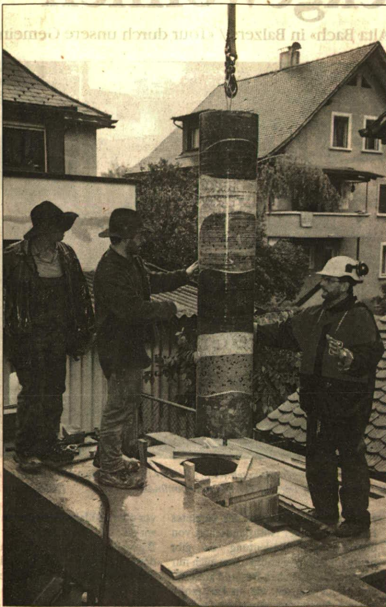
Walti Roth auf der Grossbaustelle beim Betrachten des Diamantbohrers.
