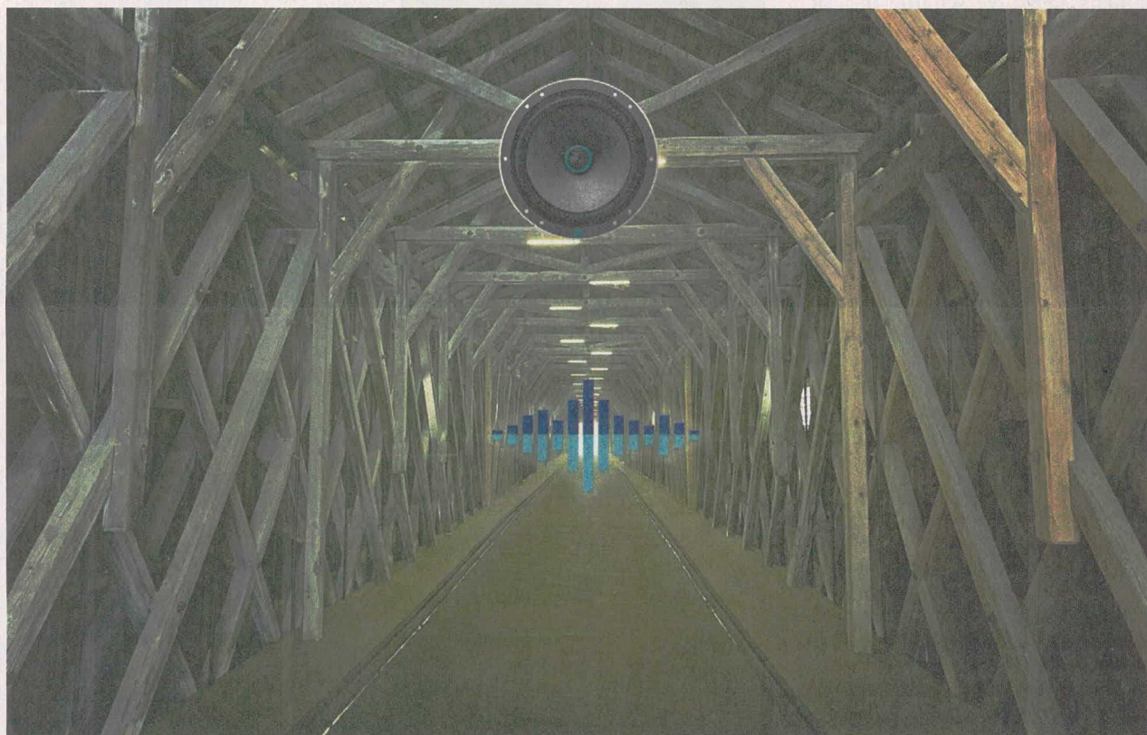
Ein komplexes Projekt: Die Illustration dient zur Sichtbarmachung, dass die Brücke bei der geplanten Live-Performance «UEBER.FLUSS» von Arno Oehri, Patrick Kessler und Ludwig Berger als Klangkörper genutzt wird. (Foto: ZVG/Arno Oehri)
