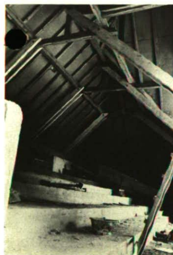
Die Galerie während und nach dem Umbau.
