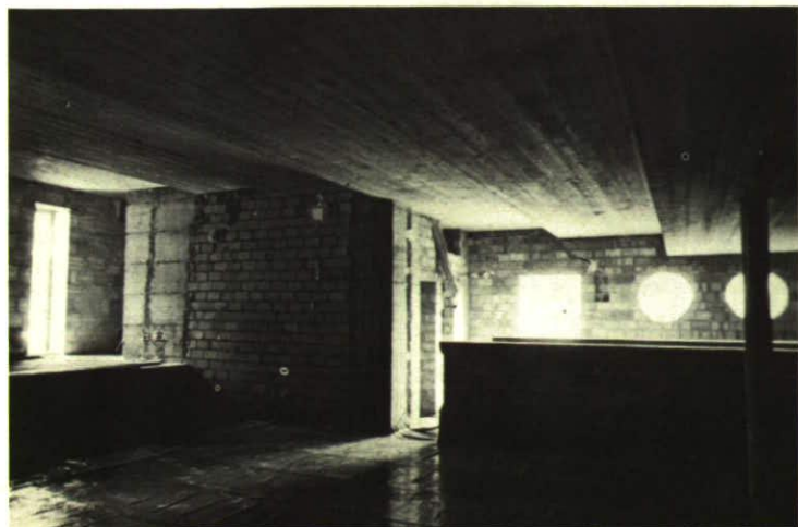
Das Foyer während und nach dem Umbau.
