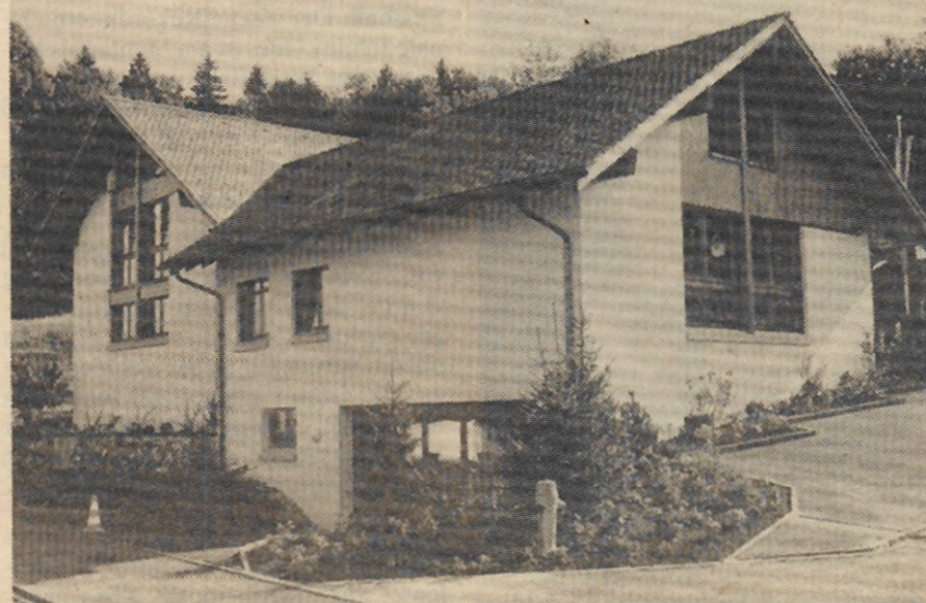
Die ruhige Lage und der verkehrssarme Zugang sind vorteilhaft. Unser Bild zeigt den Schellenberger Kindergarten von der Südseite.
