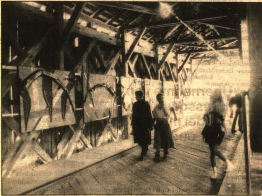
Im Innern der alten Holzbrücke Vaduz-Sevelen während der Ausstellung.
